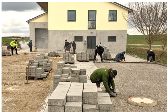
Alle pflasterten im Akkord, bis um 13 Uhr der letzte Pflasterstein ins Kiesbett fiel (Foto: Gutmann).
