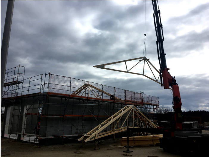
Nagelbinderkonstruktion wird aufgestellt
