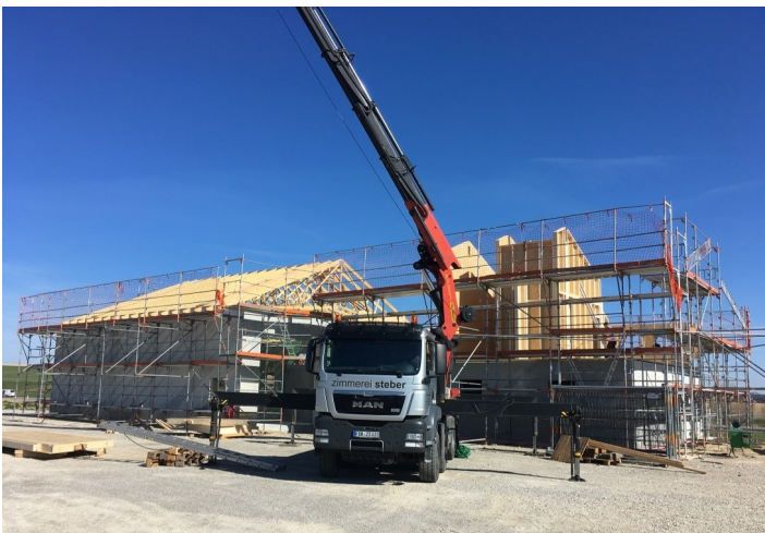
Neben der Fahrzeughalle wird der zweigeschossige Bereich aufgestellt
