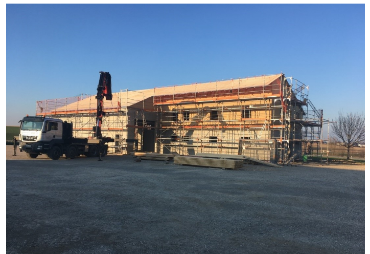
Dachschalung wird aufgestellt
