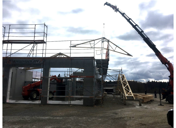
Nagelbinderkonstruktion wird aufgestellt
