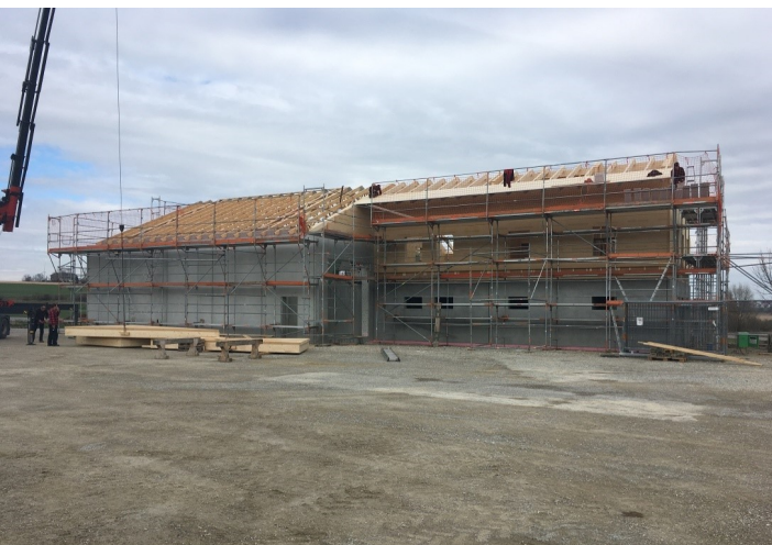
Dachschalung wird aufgestellt
